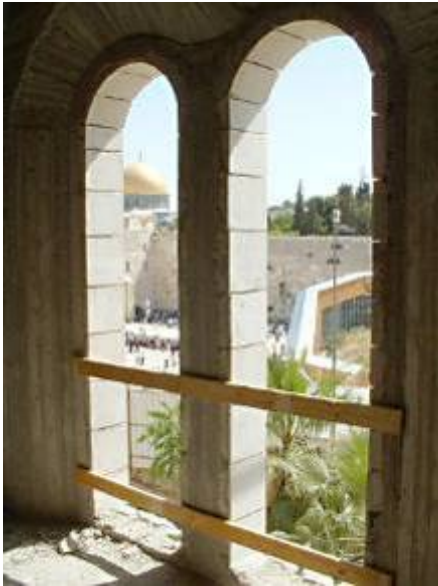
Raam van huis in aanbouw met uitzicht op de Klaagmuur
